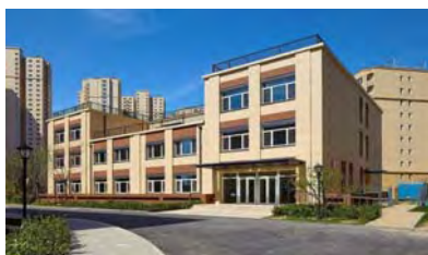
超低能耗示范项目 -- 翠成馨园 D23 居住公共服务楼
